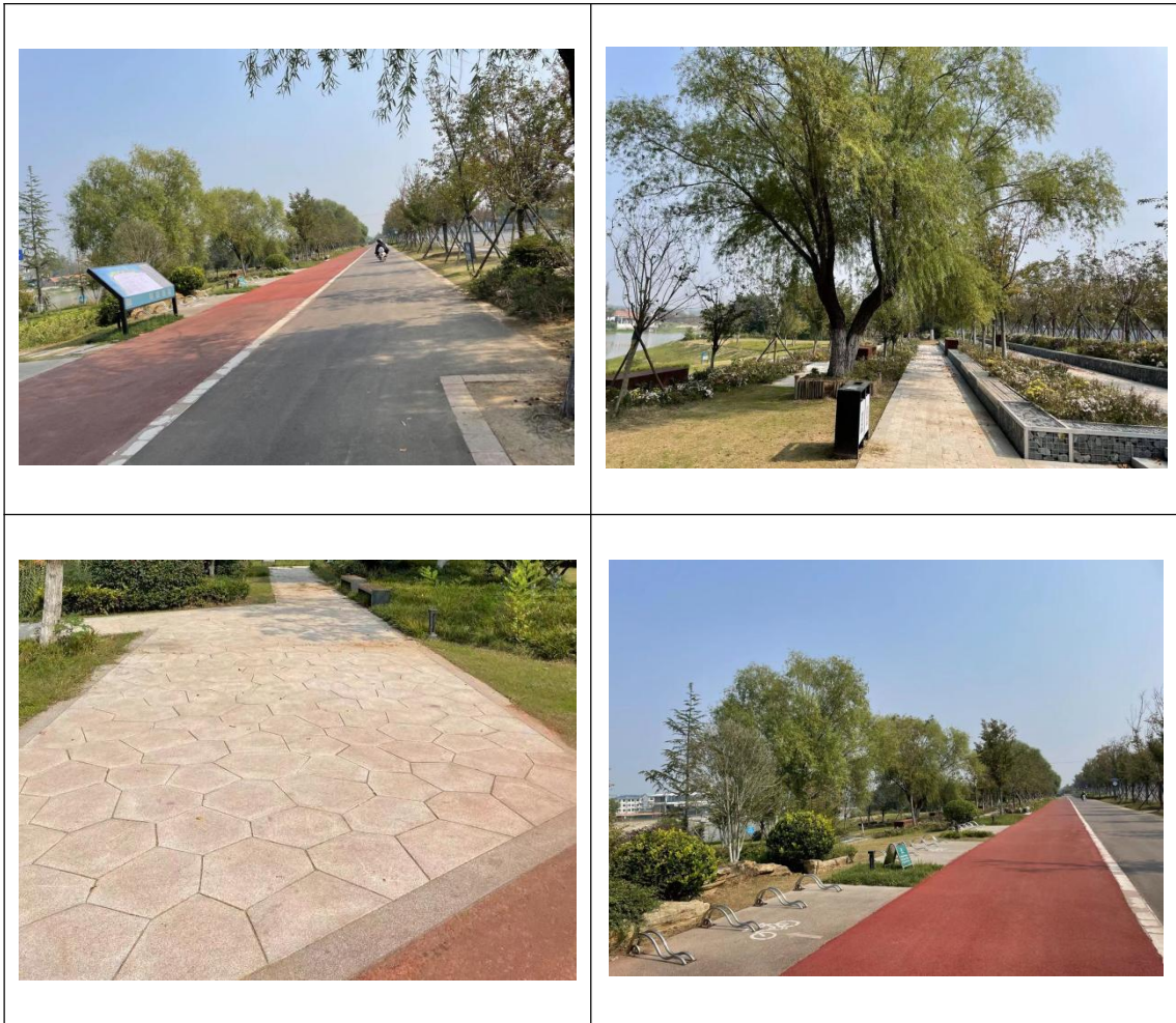
图4-1 工程措施现状（2023.10）
